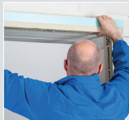
**9.** Durch Anbringung des oberen Systemwinkels entsteht die komplette Umrahmung der Fensteröffnung.
