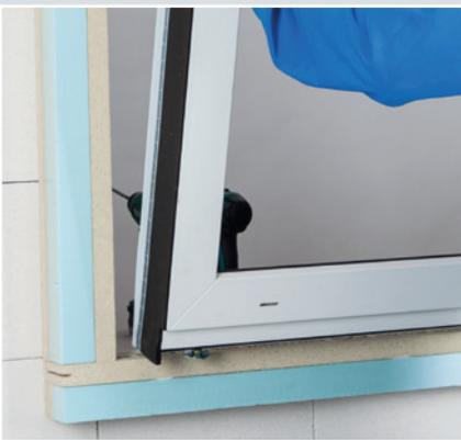
**10.** Nach erfolgter Montage der Systemwinkel werden die Fenster mit einem Multifunktionsband wie z.B. ISO-BLOCO HYBRATEC RAL-gerecht eingebaut.
