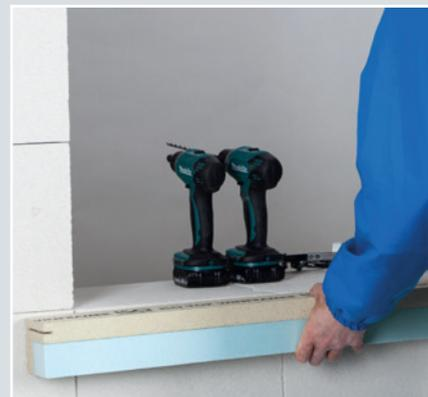
**3.** Zuerst wird der untere waagerechte Systemwinkel montiert. Dabei wird er an das Mauerwerk gedrückt und angerieben, damit sich die Klebermenge gleichmäßig verteilt.
