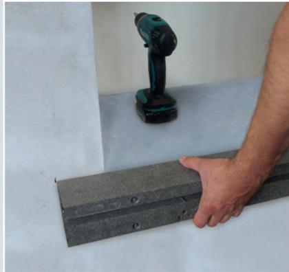
5. Begonnen wird mit der Montage der unteren waagerechten Systemkante. Nach dem Auftrag der Kleberaupen wird die Systemkante an das Mauerwerk gedrückt und angerieben.
