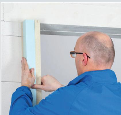
**8.** Der zweite seitliche Systemwinkel wird nach dem gleichen Montageablauf befestigt.
