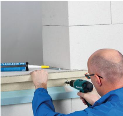
**4.** Zusätzlich werden die Systemwinkel umlaufend mechanisch verschraubt. Vor der beidseitigen Verschraubung muss vorgebohrt werden, um Ausbrüche zu verhindern.
