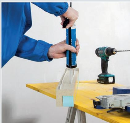
**2.** Der Systemkleber ISO-TOP FLEKKLEBER WF wird auf die Systemwinkel in 2 durchgängigen Kleberräufen aufgetragen.
