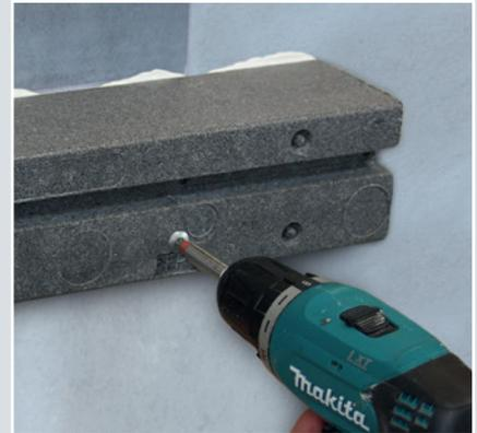
6. Zusätzlich wird die Systemkante umlaufend mechanisch verschraubt. Die zugelassenen Befestigungsschrauben müssen passend zum Mauerwerkmaterial gewählt werden und einen Flachkopf aufweisen.
