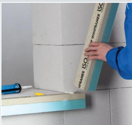
**7.** Dann wird der erste seitliche Systemwinkel im Anschluss an den unteren waagerechten Systemwinkel entsprechend montiert.
