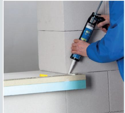
**6.** Bei der Montage der seitlichen Systemwinkel erfolgt eine luftdichte Verklebung der Stoßflächen mit ISO-TOP FLECKLEBER WF.
