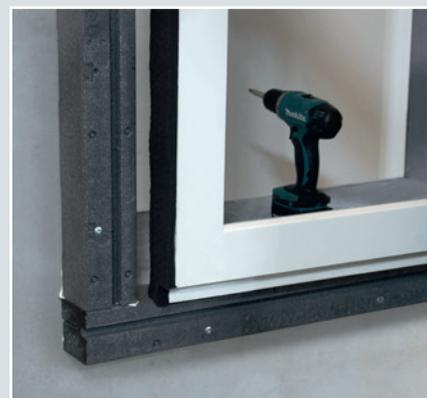
**9.** Nach erfolgter Montage der Systemwinkel werden die Fenster mit einem Multifunktionsband wie z.B. ISO-BLOCO HYBRATEC RAL-gerecht eingebaut.
