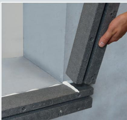
**8.** Die Montage der weiteren Systemkanten erfolgt im Uhrzeigersinn.
