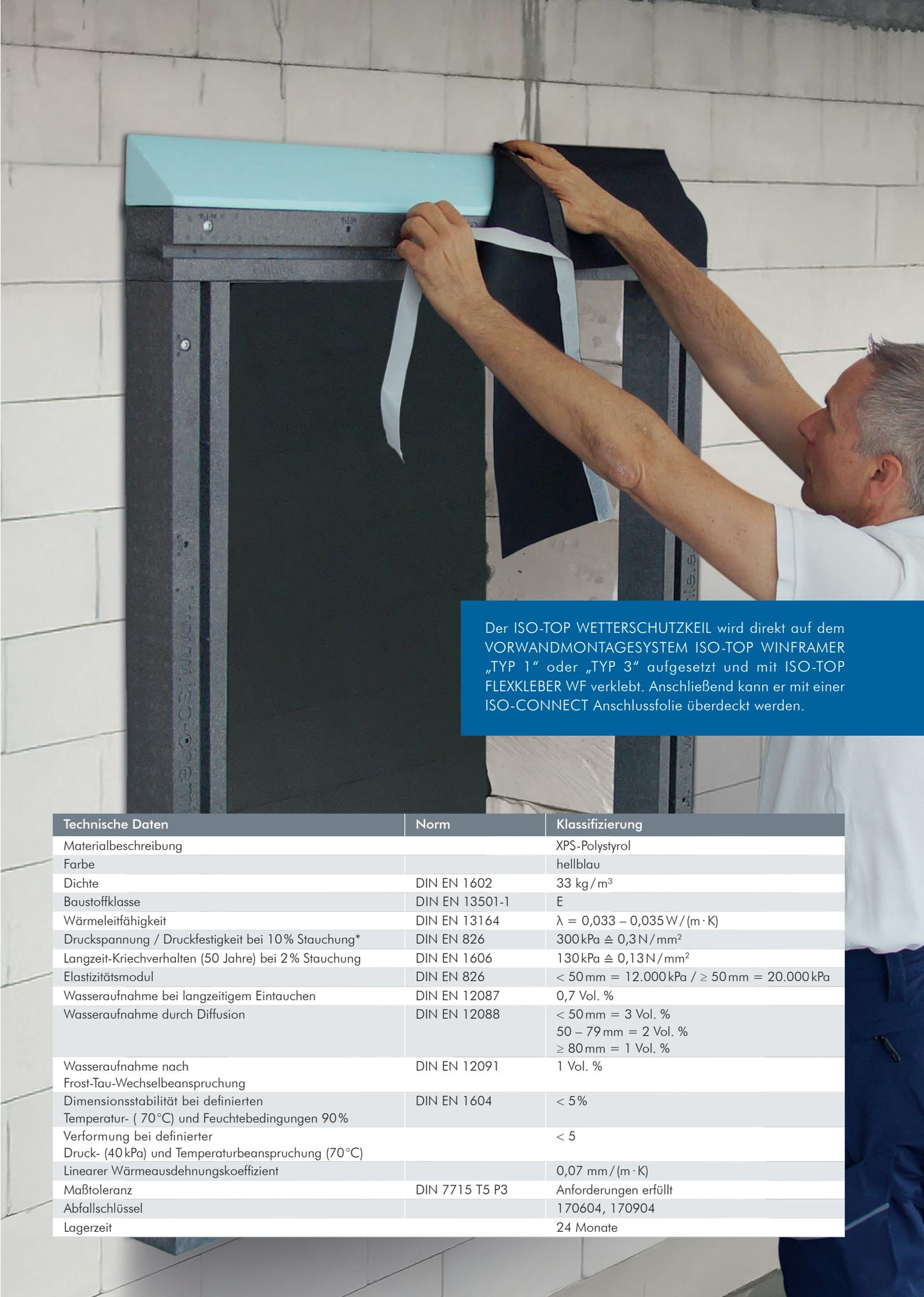
Der ISO-TOP WETTERSCHUTZKEIL wird direkt auf dem VORWANDMONTAGESYSTEM ISO-TOP WINFRAMER „TYP 1“ oder „TYP 3“ aufgesetzt und mit ISO-TOP FLECKLEBER WF verklebt. Anschließend kann er mit einer ISO-CONNECT Anschlussfolie überdeckt werden.
