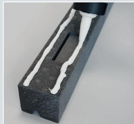
**3.** Der Systemkleber ISO-TOP FLECKLEBER WF wird auf die Systemkante aufgetragen. Für die genaue Dosierung wird die vorgeschrittene Düse eingesetzt.
