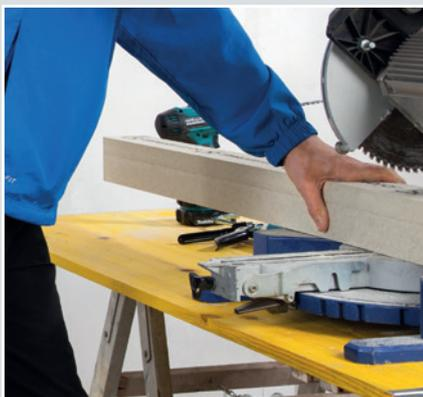
**1.** Die Systemwinkel werden auf Format zugeschnitten. Der Dämmkern bleibt dabei in eingeklapptem Zustand, sodass gleiche Anschnittflächen entstehen.
