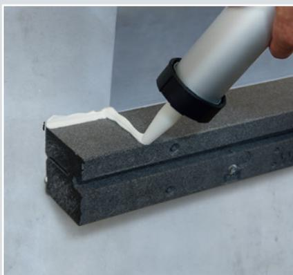
**7.** Die Stoßstellen der waagerechten und senkrechten Systemkanten müssen zusätzlich verklebt werden, um eine Luft- und Schlagregendichtheit der Systemkantelfugen zu erreichen.
