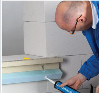
**5.** Nach der Verschraubung werden mehrere Klebepunkte auf dem Dämmkern mit ISO-TOP FLECKLEBER WF angebracht und zur Fixierung wieder zurückgeklappt.
