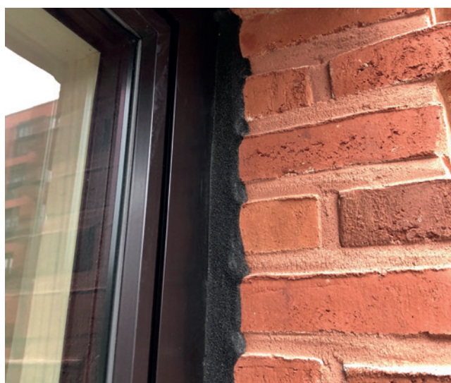
Installation example: ISO-BLOCO 600 „MAXIBOND“
