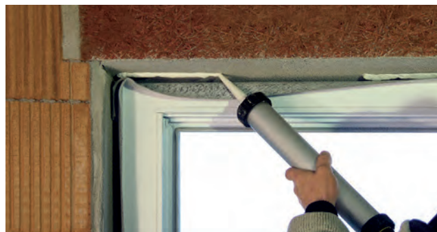
Esempio di installazione: ISO-TOP ADESIVO FLEX SP
