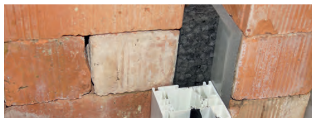
Esempio di installazione: ISO-BLOCO FILLER
