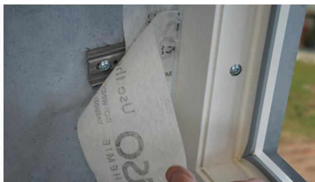
Ejemplo de instalación: ISO-CONNECT VARIO SD „PADS”
